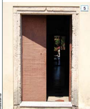
A_b 3 Porta con architrave e stipiti lapidei monolitici modanati
