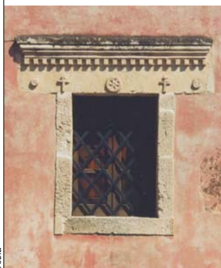
A_b 2 Finestra con architrave lapideo monolitico con decori in rilievo e stipiti lapidei monolitici
