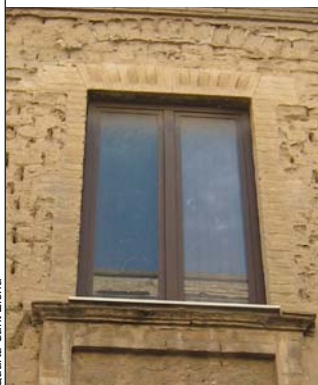
B_a 5 Finestra con piattabanda e stipiti in mattoni cotti
