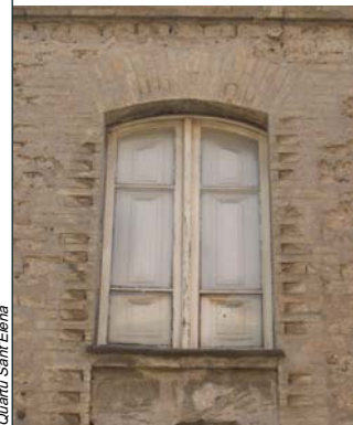
B_b 6 Finestra con stipiti monolitici squadrati con architrave monolitico in pietra e arco in conci lapidei
