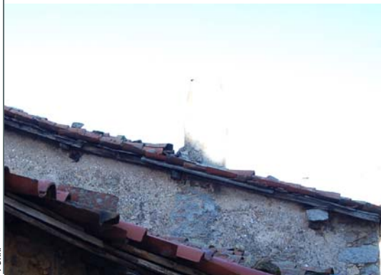
B_c 2 Coronamento di testata con singola fila di tegole convesse in aggetto retto da un travicello poggiante su mensole lignee e lapidee
