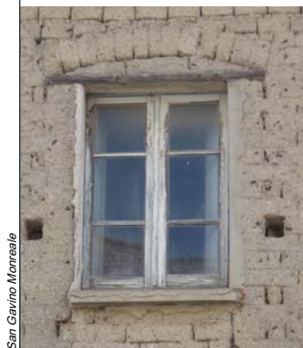
B_a 4 Finestra con piattabanda in mattoni cotti e stipiti in mattoni crudi
