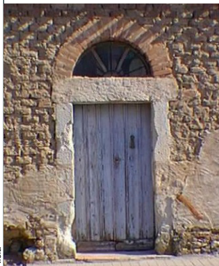
B_b 5 Porta con stipiti e traverso monolitici e arco sopra luce in mattoni cotti
