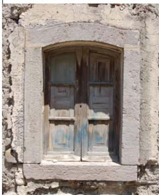
B_b 4 Finestra con stipiti e arco ribassato monolitico in pietra
