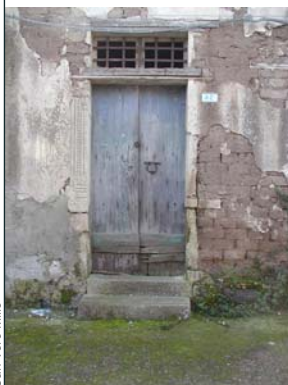
A_b 2 Porta con architrave lapideo monolitico con decori ad intaglio e stipiti lapidei monolitici
