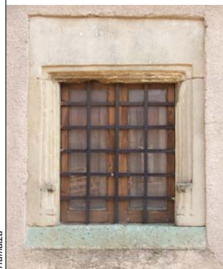
A_b 3 Finestra con architrave e stipiti lapidei monolitici scorciati
