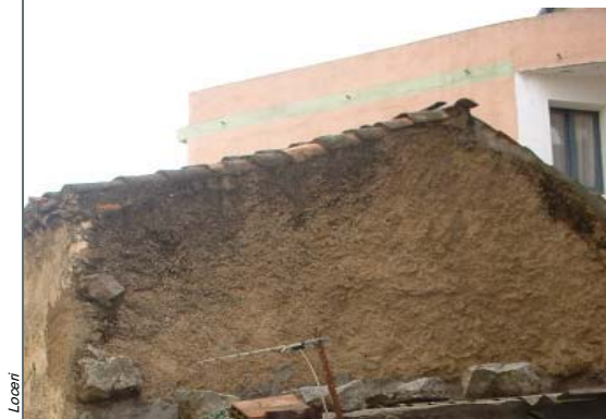
B_b 1 Coronamento di testata con semplice fila di tegole convesse posizionate su una fila di tegole poste con l'asse ortogonale alla muratura e aggettanti rispetto alla superficie del muro
