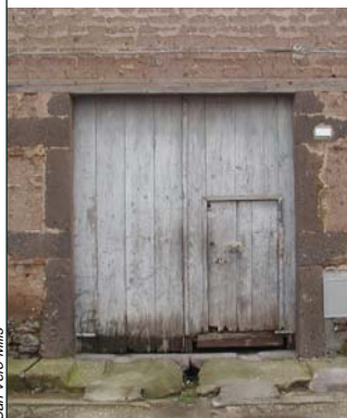
A_b 2 Portale con architrave ligneo e stipiti in elementi monolitici
