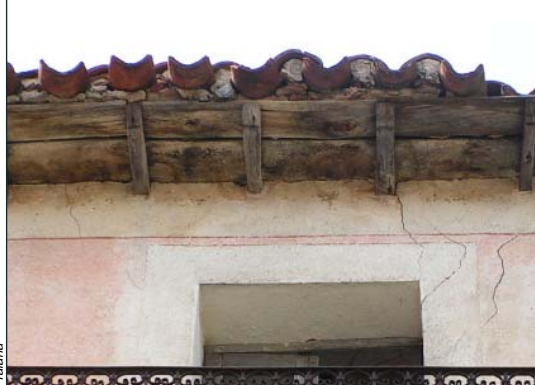
A_b 2 Cornice aggettante realizzata in laterizi o conci lapidei, priva di muretto d'attico. Smaltimento delle acque attraverso canale di gronda incassato nella cornice e pluviale esterno
