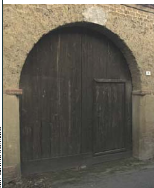
A_a 8 Arco in mattoni cotti con apparecchiatura a due teste su stipiti in elementi monolitici
