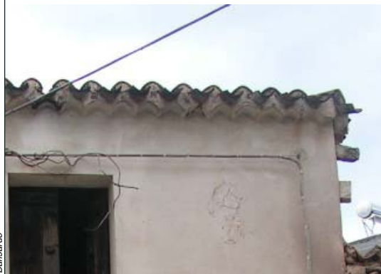
A_a 4 Aggetto con cornice realizzata con laterizi cotti o crudi con modanature e smaltimento diretto delle acque
