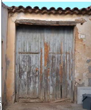
A_a 5 Portale con architrave ligneo e stipiti in conci lapidei squadrate
