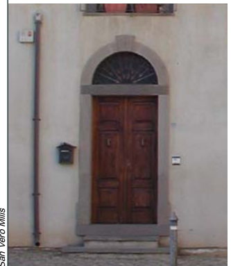
B_b 6 Porta con stipiti in conci lapidei squadrati con traverso monolitico in pietra e arco sopra luce in conci lapidei
