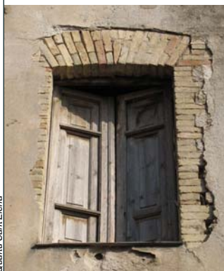
B_b 2 Finestra con stipiti in mattoni crudi e arco ribassato in mattoni cotti
