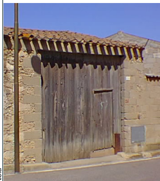
A_b 2 Portale con architrave ligneo e stipiti in elementi monolitici
