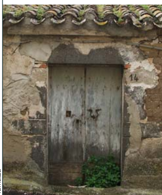
A_b 4 Porta con architrave monolitico e stipiti lapidei non monolitici
