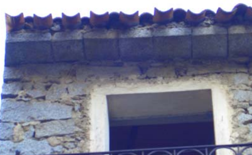
A_a 5 Aggetto semplice dei coppi canale da incannucciato su travicelli lignei aggettanti con smaltimento diretto delle acque
