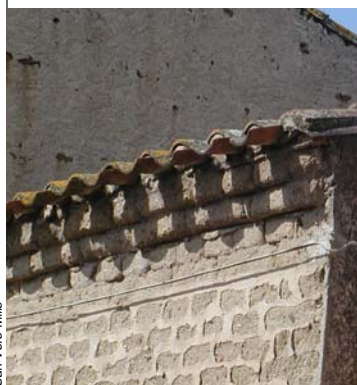
A_a 6 Aggetto con ricorsi di tavelle annegate nel cordolo
