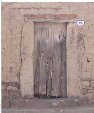
A_b 1 Porta con architrave e stipiti lapidei monolitici
