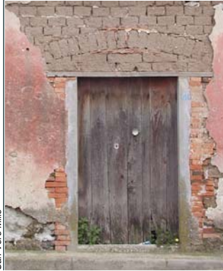
B_a 2 Porta con orizzontamento ligneo, stipiti in cotto con arco di scarico in mattoni crudi
