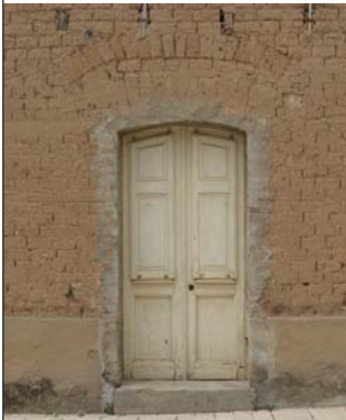
B_b 4 Porta con arco a tutto sesto in mattoni cotti su stipiti monolitici con sopra luce a lunetta e traverso ligneo
