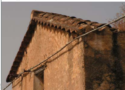
B_c 2 Coronamento di testata con singola fila di tegole convesse in aggetto retto da un travicello poggiante su mensole lignee e lapidee
