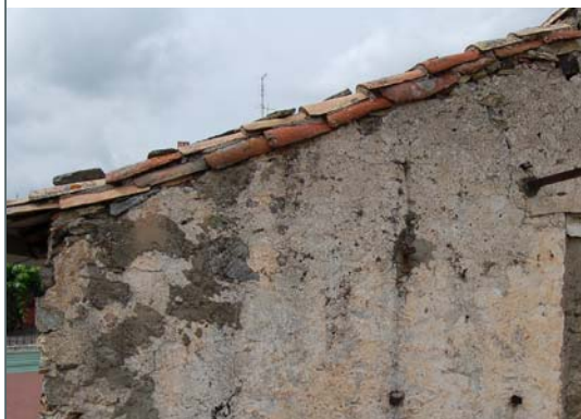
B_b 2 Coronamento di testata con doppia fila di tegole convesse, sovrapposte, disposte su una fila di tegole ortogonali alla muratura e aggettanti rispetto alla superficie del muro
