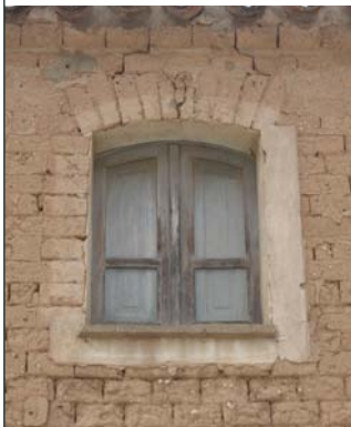
B_b 4 Finestra con stipiti e arco ribassato monolitico in pietra
