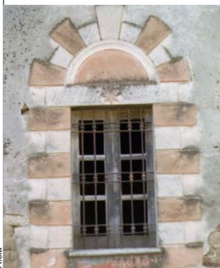
B_b 5 Finestra con stipiti in conci lapidei squadrati con architrave monolitico in pietra e arco in conci lapidei
