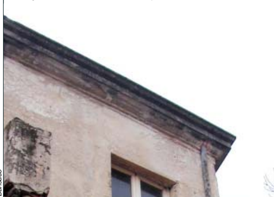
A_b 2 Cornice aggettante realizzata in laterizi o conci lapidei, priva di muretto d'attico. Smaltimento delle acque attraverso canale di gronda incassato nella cornice e pluviale esterno
