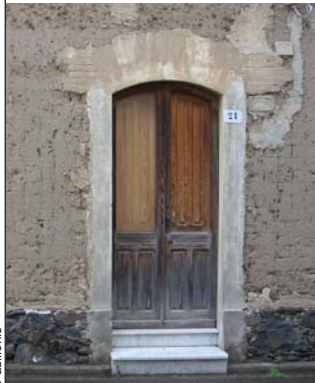
B_b 5 Porta con stipiti e traverso monolitici e arco sopra luce in mattoni cotti
