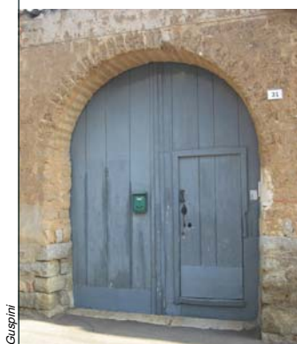
A_a 4 Arco in mattoni crudi con apparecchiatura a una testa su stipiti in conci lapidei
