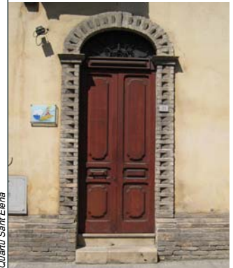
B_b 6 Porta con stipiti in conci lapidei squadrati con traverso monolitico in pietra e arco sopra luce in conci lapidei
