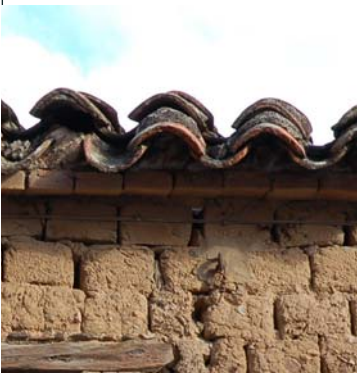
A_a 8 Incanniccato su travicelli e "canne maestre" aggettanti
