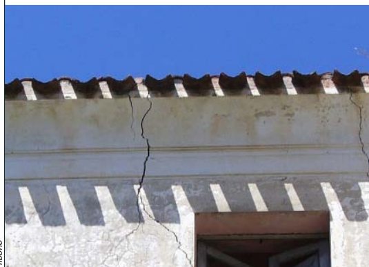
A_a 6 Aggetto semplice dei coppi canale da tavolato su travicelli lignei aggettanti con smaltimento diretto delle acque
