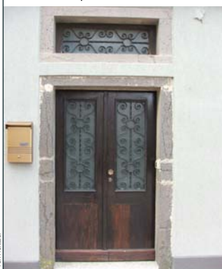
A_b 5 Porta con architrave monolitico e stipiti lapidei non monolitici e sopra luce in elementi lapidei
