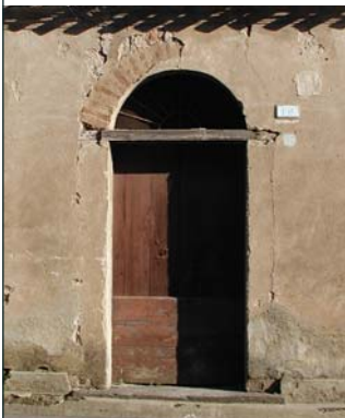
B_b 4 Porta con arco a tutto sesto in mattoni cotti su stipiti monolitici con sopra luce a lunetta e traverso ligneo
