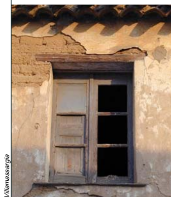
A_a 1 Finestra con architrave ligneo e stipiti in mattoni crudi
