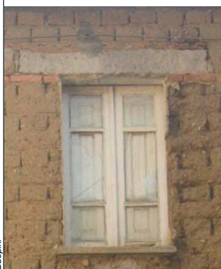
A_a 2 Finestra con architrave lapideo e stipiti in mattoni crudi
