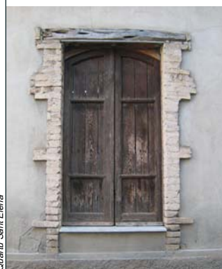
A_a 3 Finestra con architrave ligneo e stipiti in mattoni cotti
