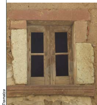
A_b 4 Finestra con architrave monolitico e stipiti lapidei non monolitici
