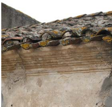
A_a 7 Aggetto con cornice in laterizi e modanatura
