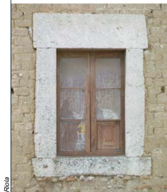
A_b 4 Finestra con architrave monolitico e stipiti lapidei non monolitici
