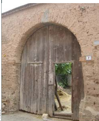
A_a 5 Arco in mattoni crudi con apparecchiatura a due teste su stipiti in mattoni cotti
