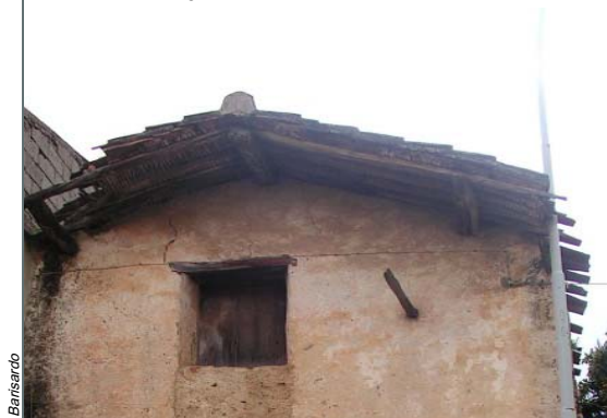
B_d 1 Coronamento di testata con doppia fila di tegole convesse sopra incanniccio disposto su travicelli lignei e canne maestre poggianti su mensole lignee
