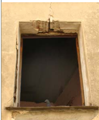
B_b 1 Finestra con stipiti e arco ribassato in mattoni crudi
