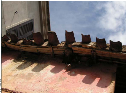
A_b 1 Cornice aggettante realizzata in laterizi o cocci lapidei, privo di muretto d'attico. Smaltimento delle acque attraverso canale di gronda e discendenti incassati nella cornice
