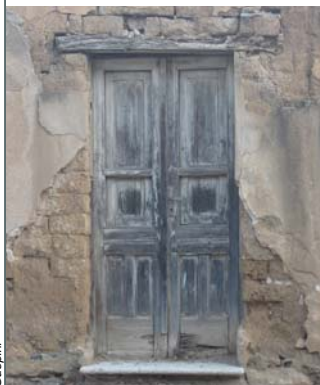
A_a 4 Porta con architrave ligneo e stipiti lapidei monolitici
