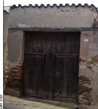
A_a 6 Portale con architrave ligneo e stipiti in mattoni cotti
