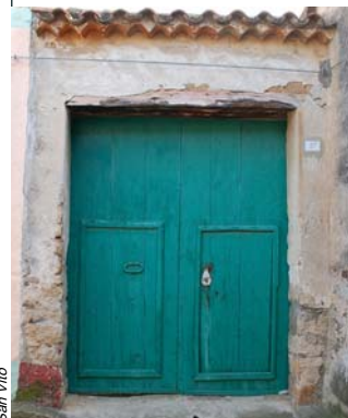
A_a 6 Portale con architrave ligneo e stipiti in mattoni cotti
