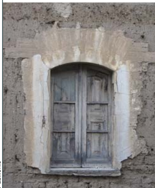
B_b 5 Finestra con stipiti in conci lapidei squadrati con architrave monolitico in pietra e arco in conci lapidei
