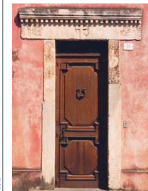
A_b 5 Porta con architrave monolitico e stipiti lapidei non monolitici e sopra luce in elementi lapidei
