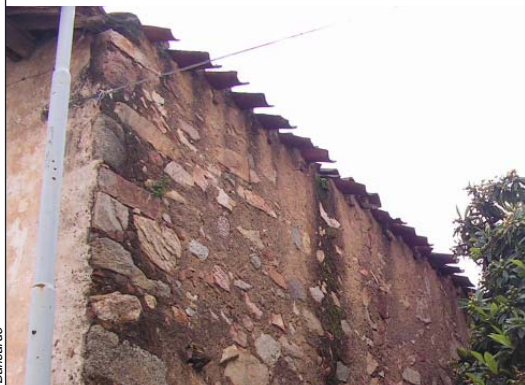
A_a 3 Aggetto dei coppi canale da cornice realizzata con semplice ricorso di conci lapidei squadrate o di mattoni di laterizio disposti di testa e smaltimento diretto delle acque
