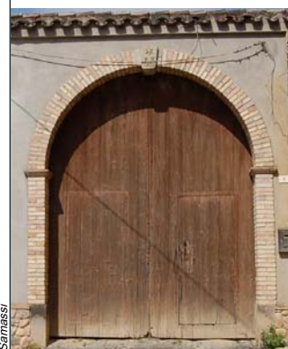
A_a 9 Arco in mattoni cotti a due teste su stipiti in blocchi di pietra squadrati
