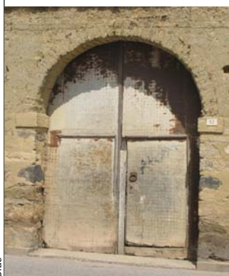
A_a 7 Arco in mattoni cotti con apparecchiatura a tre teste su stipiti in mattoni cotti
