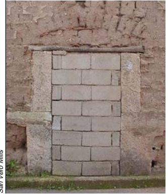
B_a 3 Porta con orizzontamento ligneo su stipiti lapidei e arco di scarico in cotto
