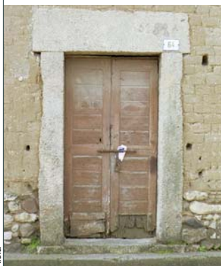
A_b 4 Porta con architrave monolitico e stipiti lapidei non monolitici
