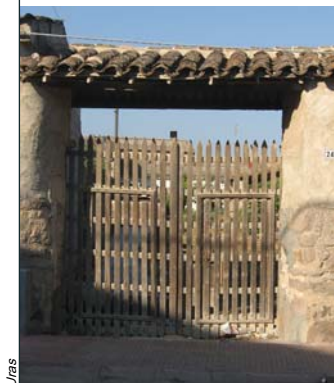
A_a 4 Portale con architrave ligneo e stipiti monolitici
