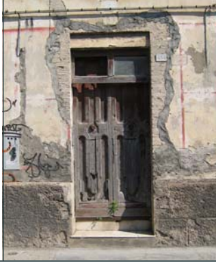
B_b 1 Porta con stipiti e arco ribassato in mattoni crudi con o senza arco di scarico sovrastante in mattoni crudi
